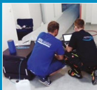
Abdichtung in einem Gewerbeobjekt
