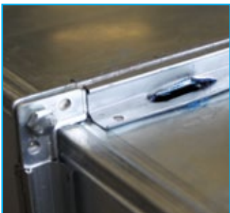
Ausgangssituation ist ein für die Abdichtung erzeugter 5x30mm Spalt.
