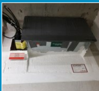
Abb. 1: Luftdichter Verschluss der Luftleitung
