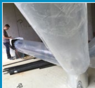
Abb. 3: Verbindung mit dem Luftleitungsnetz
