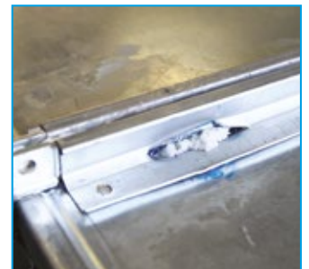
Nach etwa 30 Minuten ist die Abdichtung abgeschlossen und dauerhaft dicht.
