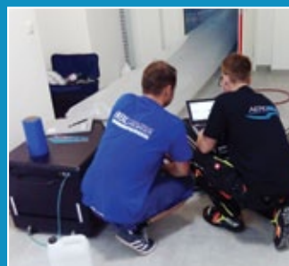
Abdichtung in einem Gewerbeobjekt
