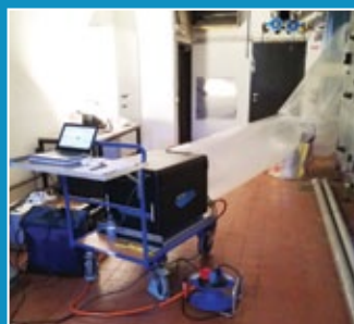
Abdichtung in einem Laborgebäude
